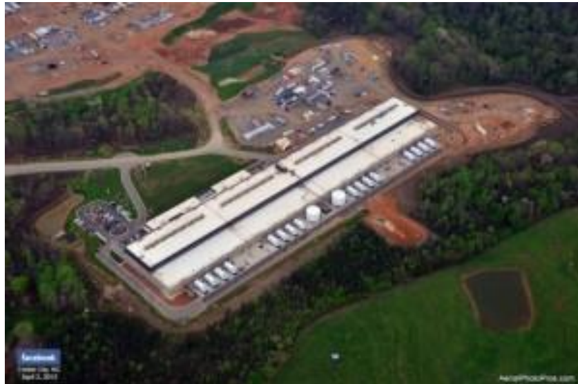
Figura 5.3.- Centro de proceso de datos Forest City, Carolina del Norte (EEUU).
